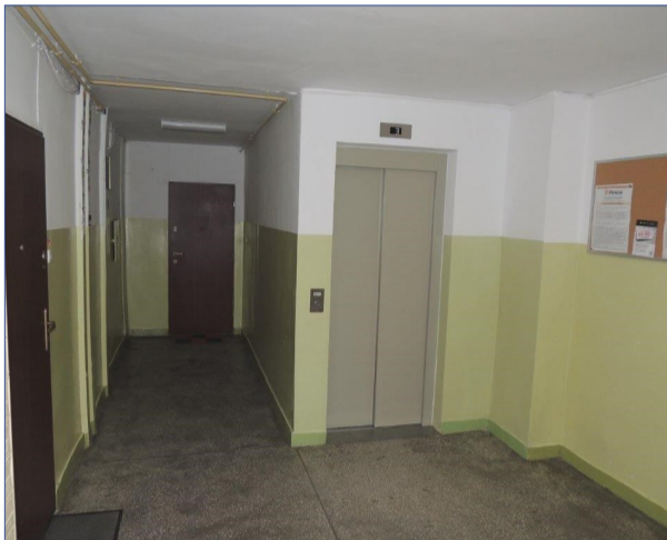
Klatka w budynku Śreniawitów 5 przed remontem
