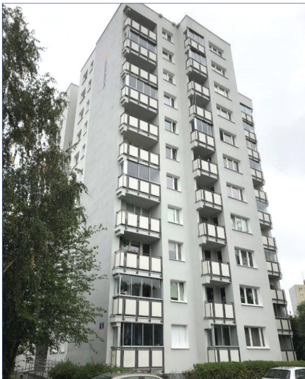
Budynek Myszowska 4 po termomodernizacji
