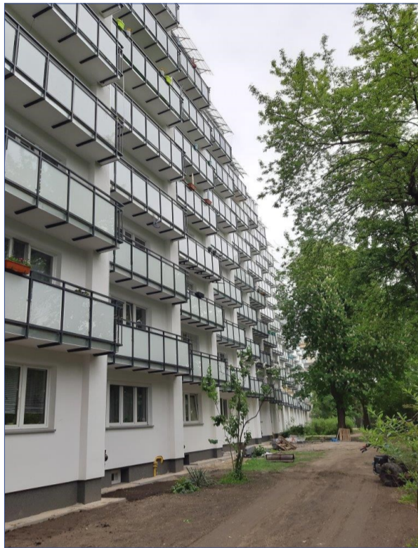
Budynek Jagiellońska 62 po remoncie i termomodernizacji
