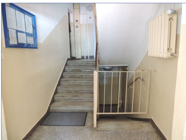
Pancera 15 - klatka schodowa przed remontem
