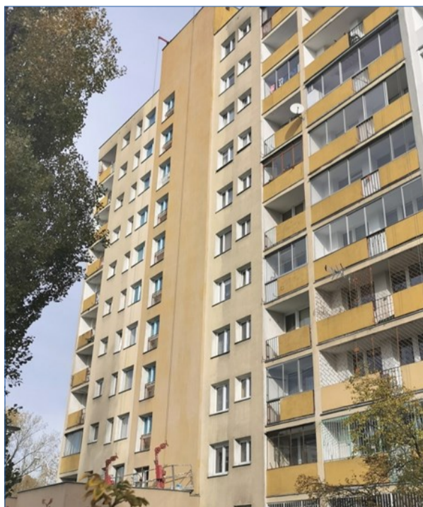
Budynek Radzywińska 68/72 przed remontem elewacji
