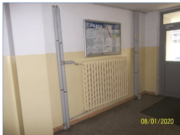
Prałatowska 6 klatka schodowa przed remontem
