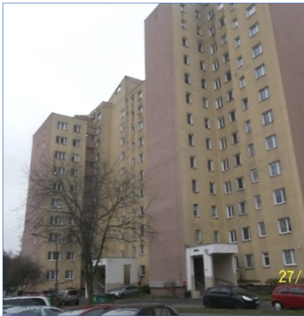
Budynek Kołowa 2 przed remontem
