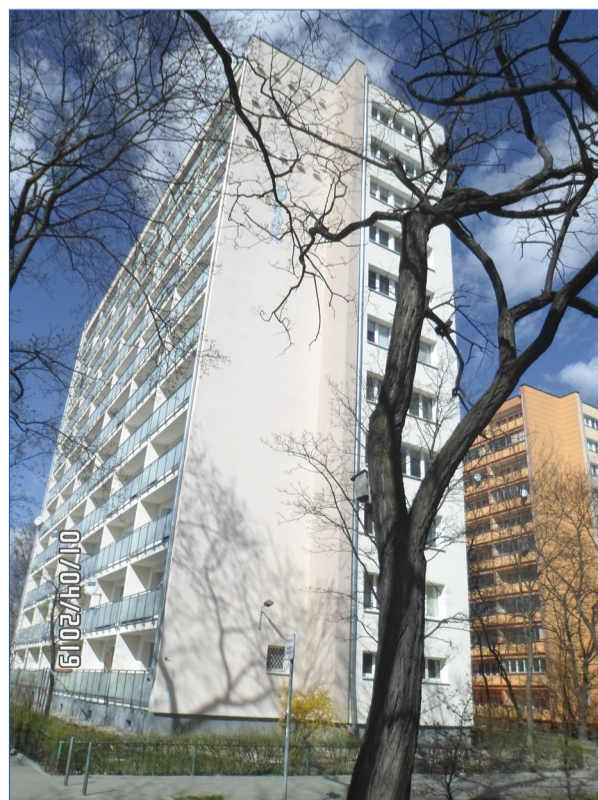
Budynek Jagiellońska 64 po remoncie
