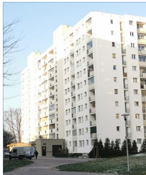
Budynek Radzywińska 68/72 w trakcie remontu elewacji
