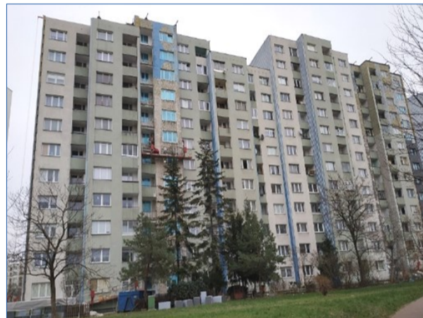
Budynek Janinówka 11 przed remontem
