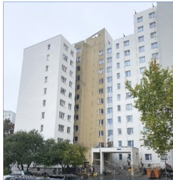
Budynek Kołowa 2 w trakcie remontu
