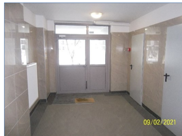
Prałatowska 6 klatka schodowa po remoncie
