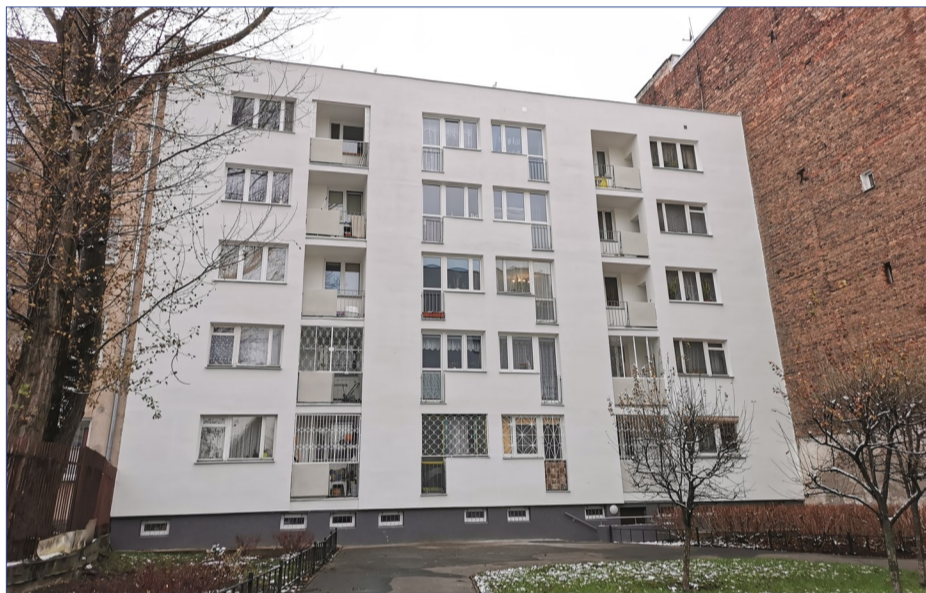
Budynek Tarchomińska 10 po remoncie elewacji
