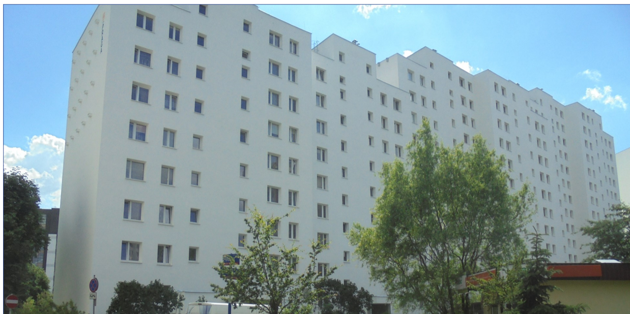
Budynek Janinówka 9 po remoncie.
