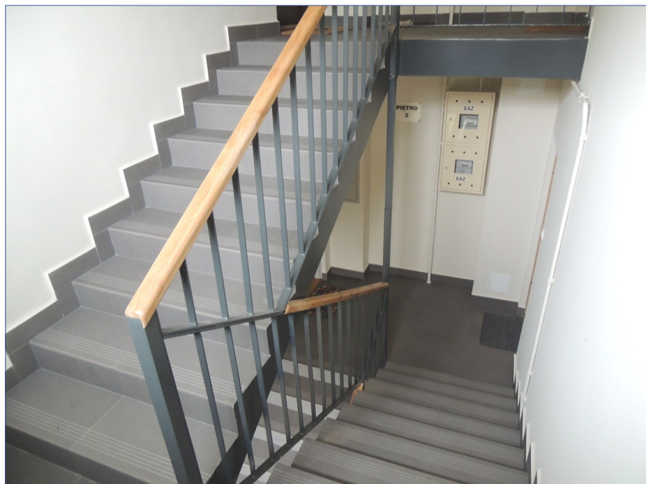
Atutowa 1 klatka schodowa po remoncie
