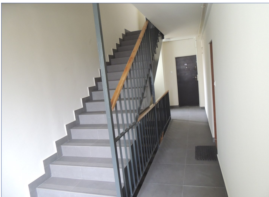
Atutowa 1 klatka schodowa po remoncie
