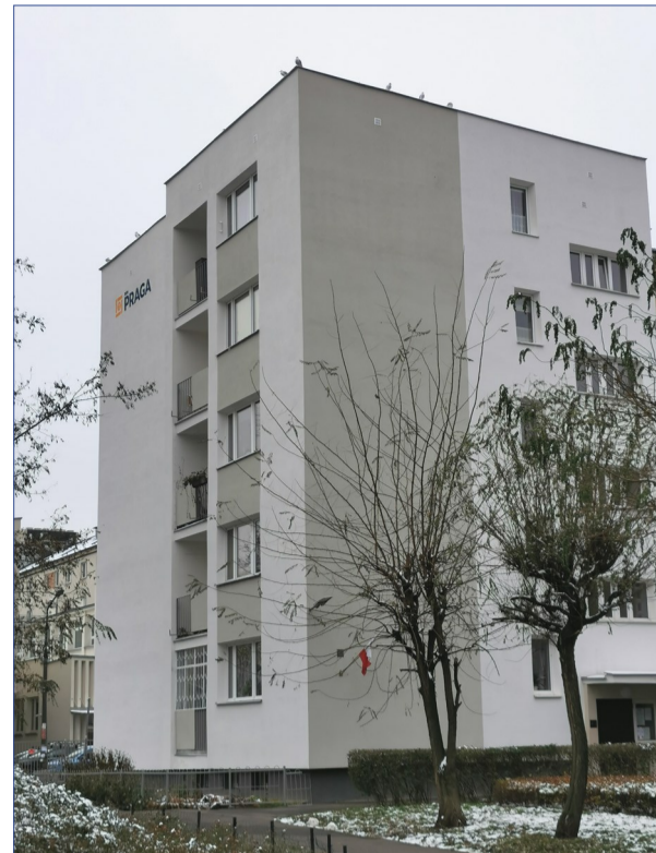
Budynek Wiosenna 1 po remoncie elewacji
