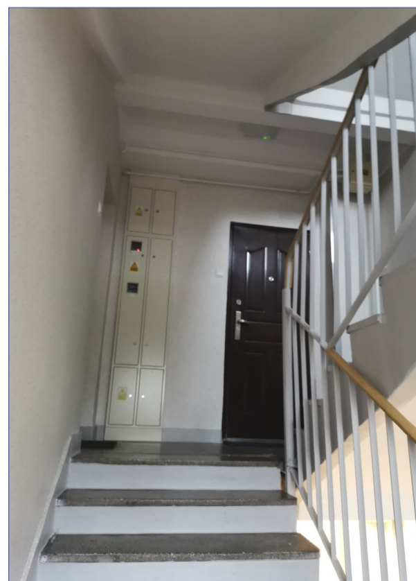
Łomżyńska 22/24 klatka schodowa po remoncie
