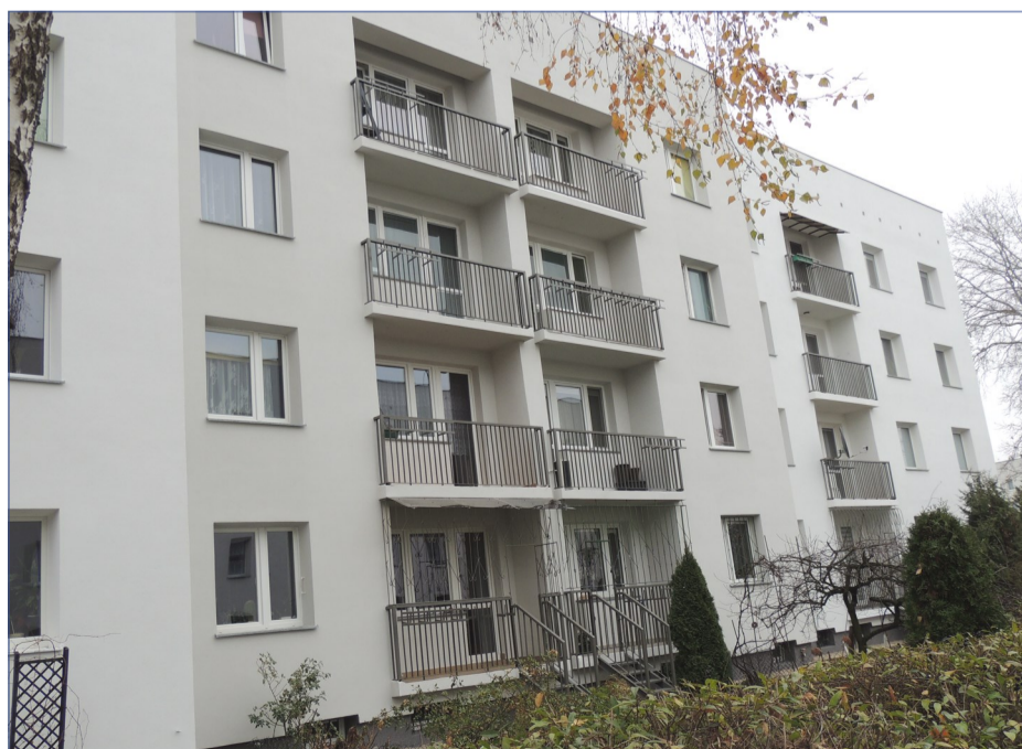
Pancera 12 po renowacji elewacji
