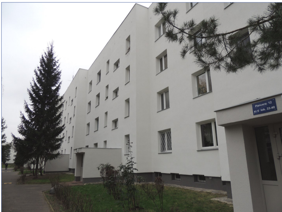
Pancera 12 po renowacji elewacji
